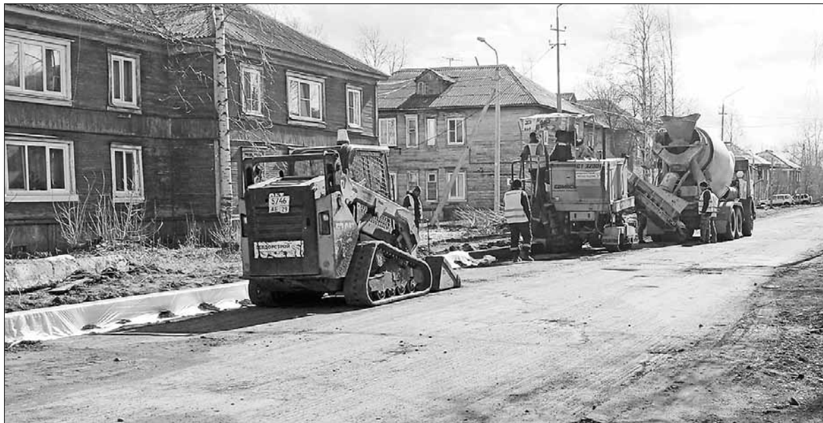
■ Ремонт дорожного покрытия на улице Орджоникидзе
