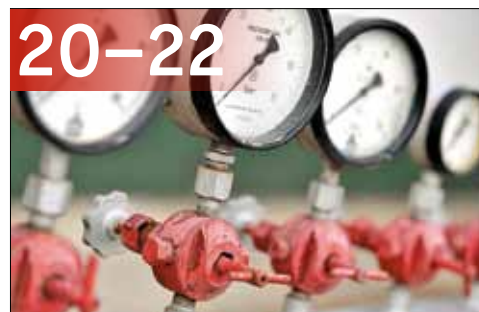
Перечень жилых домов и объектов соцсферы, отключаемых для ремонта тепловых сетей
